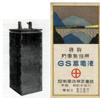
写真3 列車点灯用鉛蓄電池とカタログ 50)
