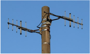
写真15 P型列車無線の基地局アンテナ (日豊本線の駅にて 令和5年4月, 撮影 加島 篤)
