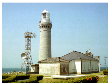
写真15 角島灯台に併設された多重無線通信回線用中継所(加島 篤 撮影, 平成12年5月)
