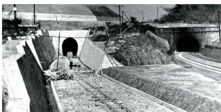
写真4 城山隧道(上り線用)新設工事 (日本国有鉄道西部支社発行「九州電化」より)
