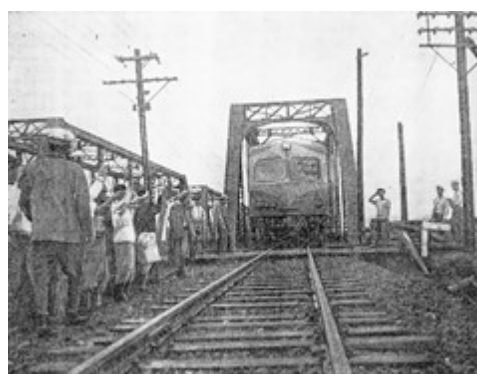
写真3 鹿児島本線遠賀川橋梁を渡るキハ44100形気動車(昭和28年7月3日付 毎日新聞西部夕刊より)
