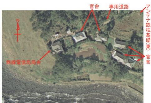
写真5 角島無線電信局跡 (国土地理院空中写真CCG-76-12[昭和51年撮影]の一部に加筆)
