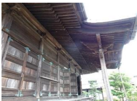
図8. 永照寺本堂側面の造り
