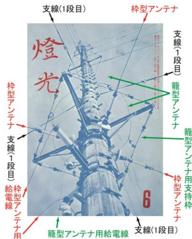
写真6 鯨角無線方位信号所の送信アンテナ支持柱 (昭和36年頃、「燈光」昭和36年6月号の表紙写真に加筆)
