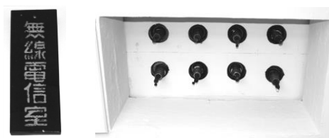
写真9 無線電信室入口の室名札と天井の貫通端子(現存)
