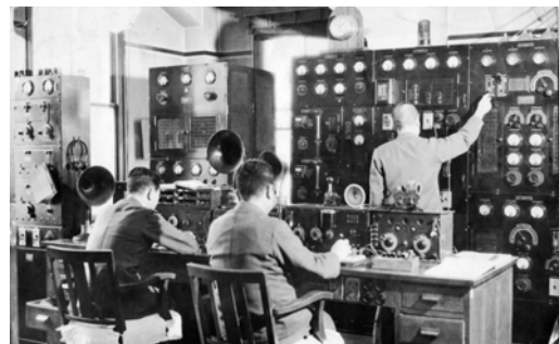
写真2 戸畑漁業無線局無線電信室(撮影年不明) (ニッセイパイオニア館所蔵資料より)
