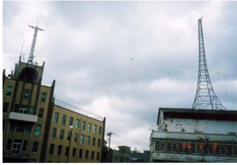
写真6 突風で破損した戸畑漁業無線局のコンカルアンテナ (平成8年3月) (重安敬雄氏提供)
